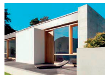
Maisons individuelles Einfamilienhaus
